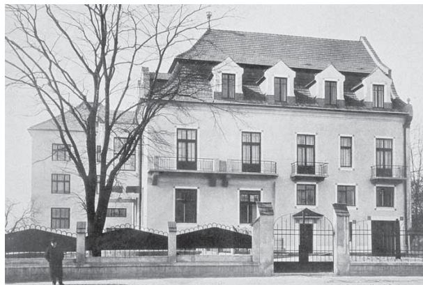
Ryc. 1. Budynek Lecznicy Związkowej (lata 20. XX w.)
